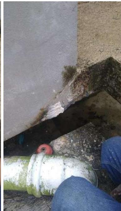
3. A partir del 21 de marzo, se procede a realizar revisión interna de los tanques con el fin de descartar posibles filtraciones a futuro. Para esta actividad fue necesario retirar cuidadosamente el material filtrante y así garantizar la efectividad de los trabajos a realizar.
