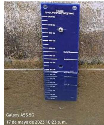
Con el fin de verificar que el caudal de llegada a la planta de tratamiento de agua potable del municipio de el Playón cumple con lo requerido de acuerdo con los diseños, se procede a poner en funcionamiento el desarenador construido y se direcciona todo el fluido hacia la planta.
